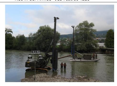
Die Stahlträgerbrücke ist auf Holzpfählen aufgebaut. Die Pfähle werden mit der Ramme im Flussbett verankert. Für den Rückbau wird ebenfalls die Ramme verwendet. Mit dem neuen Mehrzweckwagen Fastrac 4220 ist der Pfahlrückbau vom Ufer aus möglich. Zum Einsatz kommt dieses Fahrzeug insbesondere auch wenn Pfähle beim Rammen im Flussbett nicht richtig greifen und wieder ausgezogen werden müssen. Der Fastrac ist wie der Name sagt ein schneller und vielseitig einsetzbarer Traktor.
