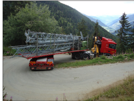
Demontage und Entsorgung alter Liftanlagen
