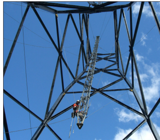
Montage einer Seilbahnstütze
