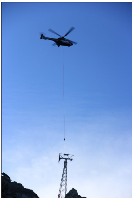
Stützen-Demontage per Hubschrauber
