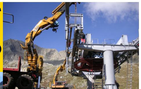
Montage einer Seilbahnstütze
